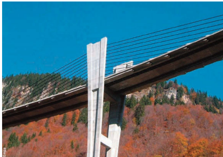
Sunnibergbrücke von Christian Menn, Umfahrung Klosters. Ein neueres Bauwerk, das auf exemplarische Weise den ästhetisch und funktional überzeugenden Umgang mit Materialien und Systemen zeigt.
