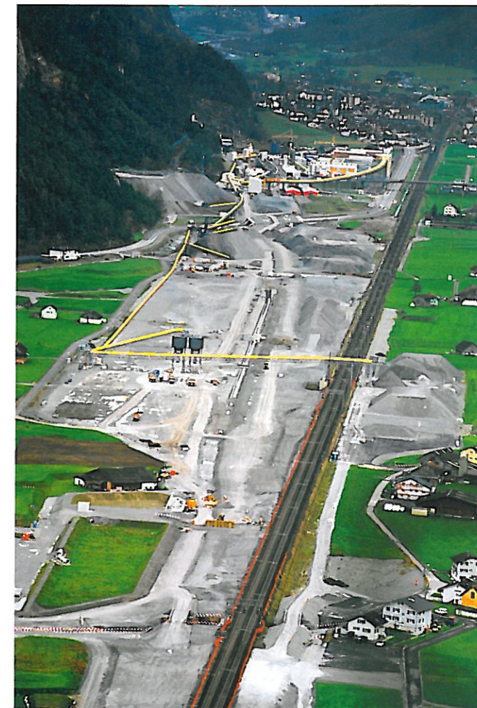
Die Aussenbaustelle am Gotthard-Portal in Erstfeld beim Anflug mit dem Helikopter: Bauen unter Betrieb.
